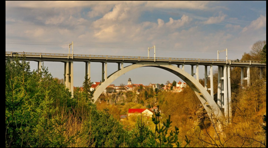
Vlevo - Dlouhý most v Českých Budějovicích – Roman Koucký, 1999 Vpravo most Duha v Bechyni, Eduard Viktora, 1928, Kamenný most v Písku, 13. století
