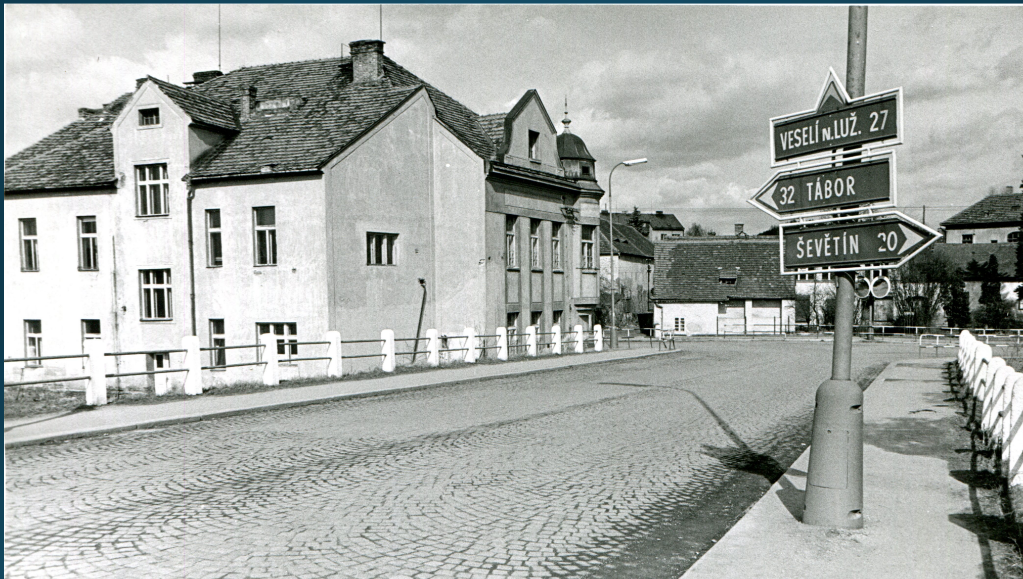
Pohled z Mostu 28. října (tzv. Nového mostu) na pravý břeh, budova záložny - OÚNZ těsně před demolicí, snímek z 15. 3. 1981. Archiv Městského muzea Týn nad Vltavou
